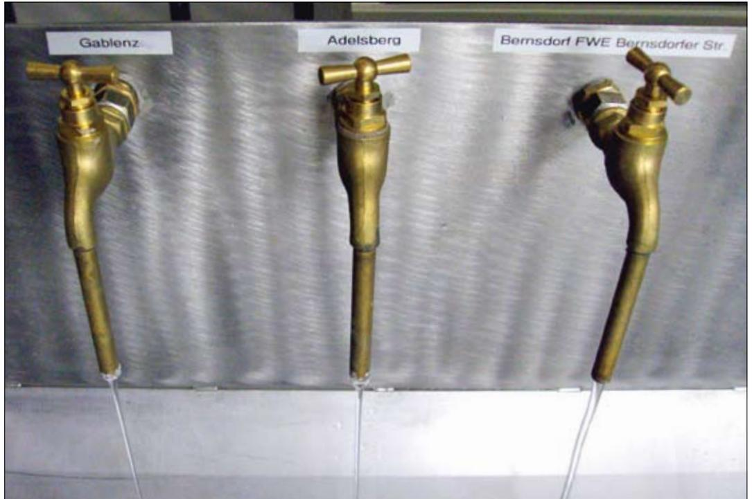
Im Pumpwerk an der Zschopauer Straße, Ecke Clausstraße, fließt aus diesen Messinghähnen ununterbrochen Wasser, um jederzeit Proben zum Test der Wasserqualität entnehmen zu können.
